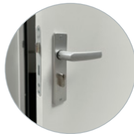
Houten toegangsdeur met houten kozijn
